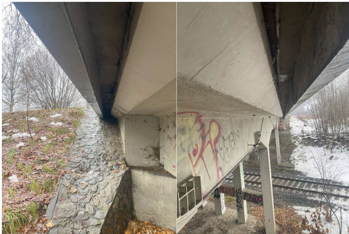
Obr. 3 – detail průvlaku pod betonovými prefabrikáty
