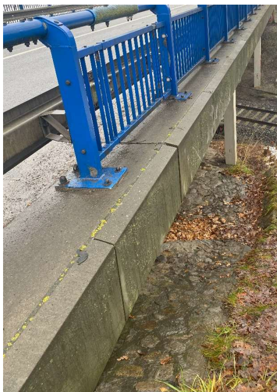
Obr. 2 – betonové prefabrikáty
